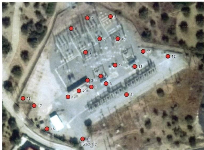
Φωτογραφία 3: Άποψη των σημείων μέτρησης, σε χώρους των εγκαταστάσεων του Υ/Σ 150kV
