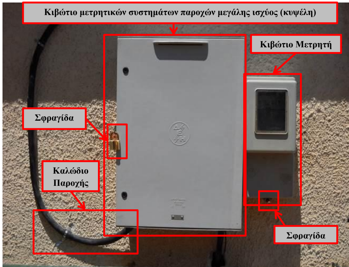
Εικόνα 10: Μετρητική διάταξη παροχών μεγάλης ισχύος.
